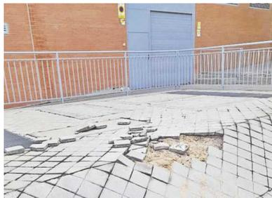
clinadas, sea eliminada la arena y en su lugar se pongan adoquines de hormigón prensado, sobre malla anti-hierbas.
