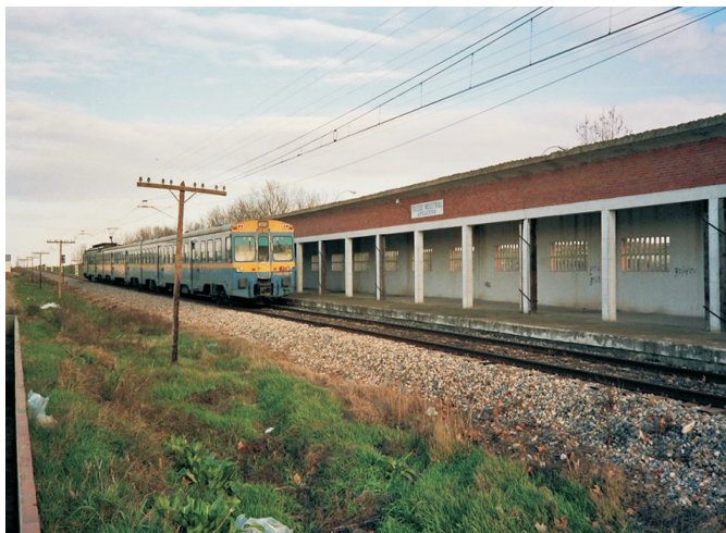
Antiguo apeadero de la línea Toledo-Madrid en el Polígono.
