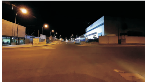
Antes y después de la iluminación de la calle Jarama.
