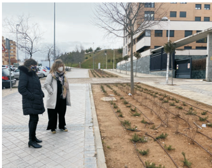
Las concejalas visitaron la intervención en la calle Valdehuesa.
