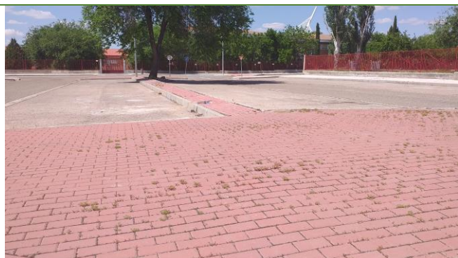
Ejemplo de parterre necesita naturalizar. Valdemarías detrás de la Iglesia y CEIP G. Manrique.
