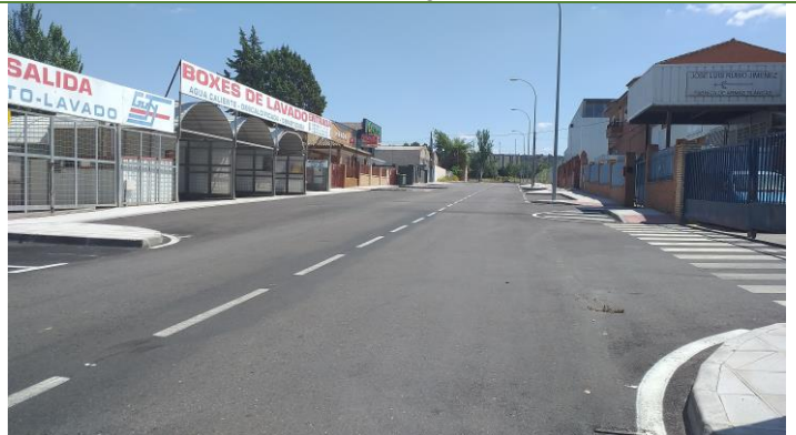
Ejemplo de obra nueva sin tener en cuenta la naturalización. Zona industrial. Valdelospozos.
