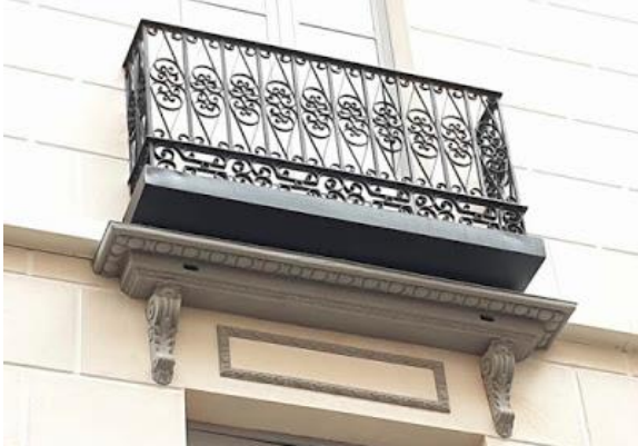
Ejemplo instalación cajas nido en fachadas para vencejos. Segovia.
