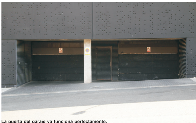
La puerta del garaje ya funciona perfectamente.
