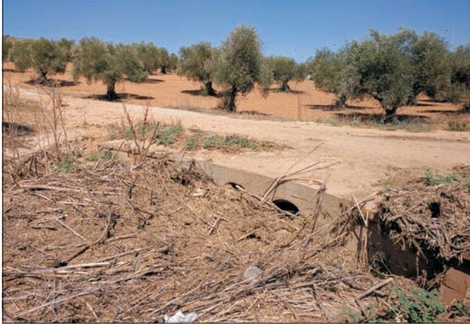
Tuberías del puente cegadas después de la tormenta.
