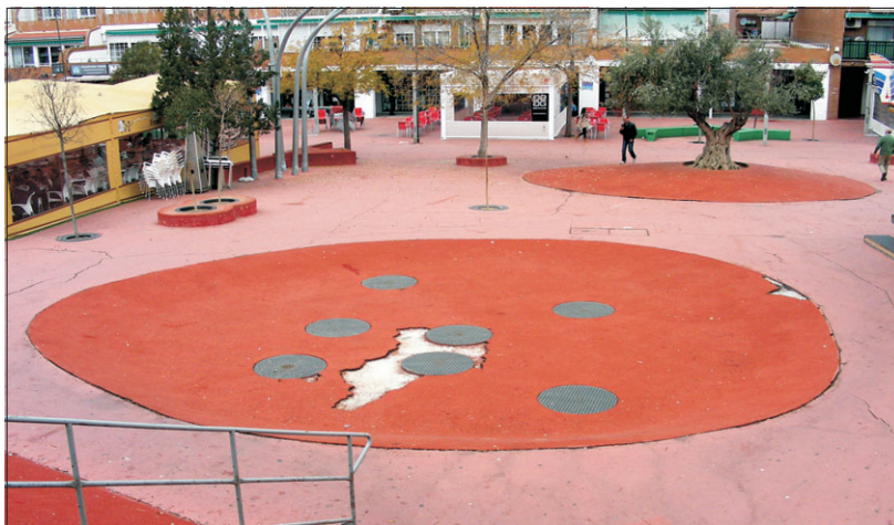
El Paseo Federico Gª Lorca necesita reparaciones.
