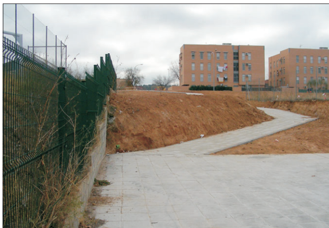
Ganamos en accesibilidad pero las obras no se hacen de la mejor forma.
