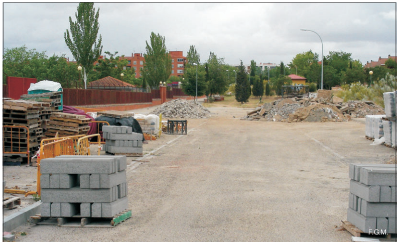
Comienzo de las obras en Manuel Machado que corresponden al proyecto del año pasado.
