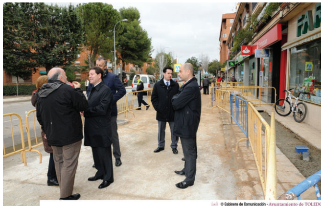
Visita del Alcalde a las obras de renovación de la red de agua.
