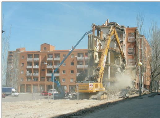
Instantánea del proceso de demolición del tercer portal del conjunto de las 48 Viviendas Sociales.
