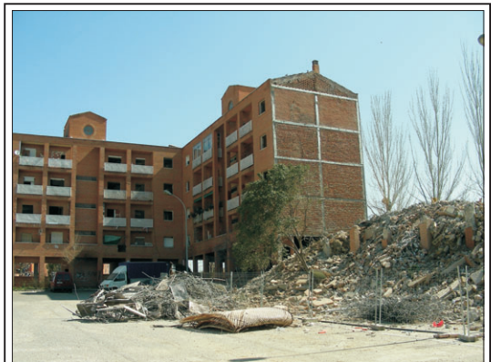
FOTO DEL MES. Lo que hace poco tiempo nos parecía imposible de lograr se está llevando a cabo. El tercer portal de las 48 Viviendas Sociales, ha sido demolido, con este son 24 las viviendas que ya han desaparecido en el proceso de desalojo y reordenación de la zona.
