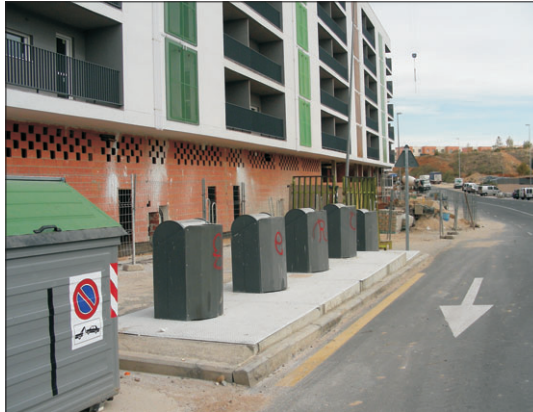
Hay que cambiar estos contenedores para que sean útiles.
