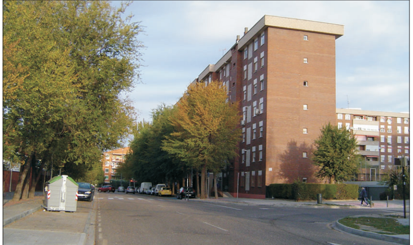
Las viviendas de la zona de la calle Valdemarias, son de las más afectadas por los olores dada su proximidad.
