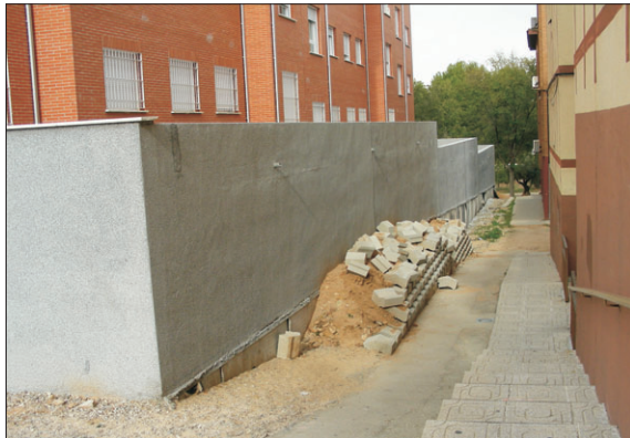
Estado del acceso a las viviendas.
