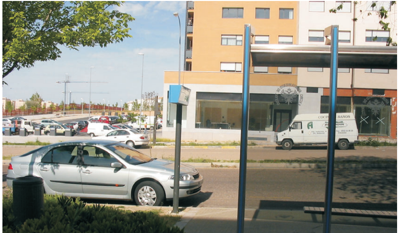
Las obras propuestas para restaurar los defectos de la III Fase, sigue sin observar cuestiones tan elementales como este paso de peatones entre dos paradas de autobús en ambas aceras.
