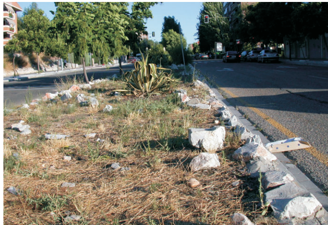
La mediana de Guadarrama, en estado lamentable.
