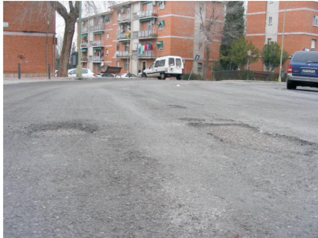
susodicho fresado se ha realizado en contadísimos lugares, y si quiere puede ver en el barrio como en algunos lugares el asfalto se ha levantado por diversas causas, entre ellas por lo escaso de la capa y por falta de ese fresado.
