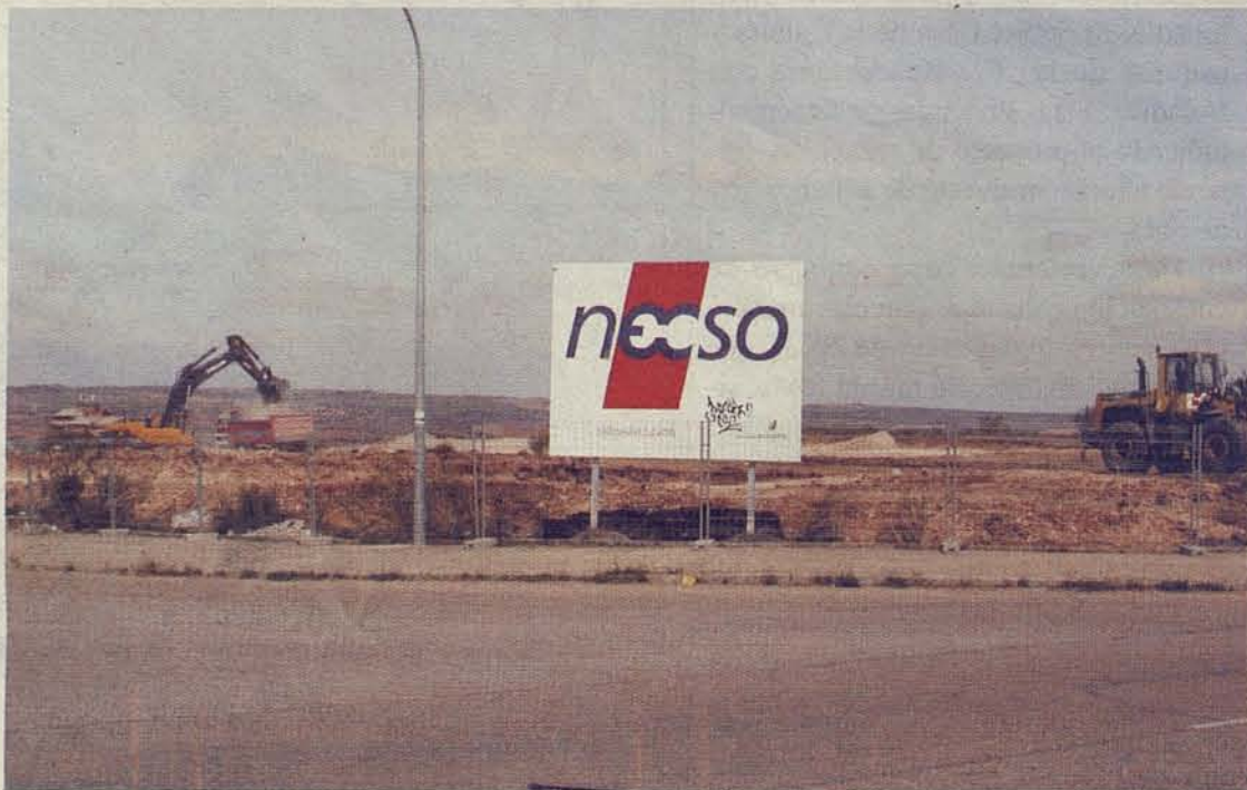
Han comenzado las obras de urbanización de la 3ª fase, paralelamente como muestran la foto la construcción de viviendas de la Cooperativa Atalaya 120
