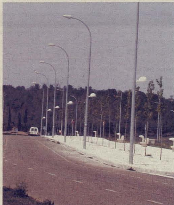
La Junta de Comunidades podría poner en marcha el alumbrado de parte de la fase 5ª sin el Ayuntamiento se hace cargo de la factura de la energía.
