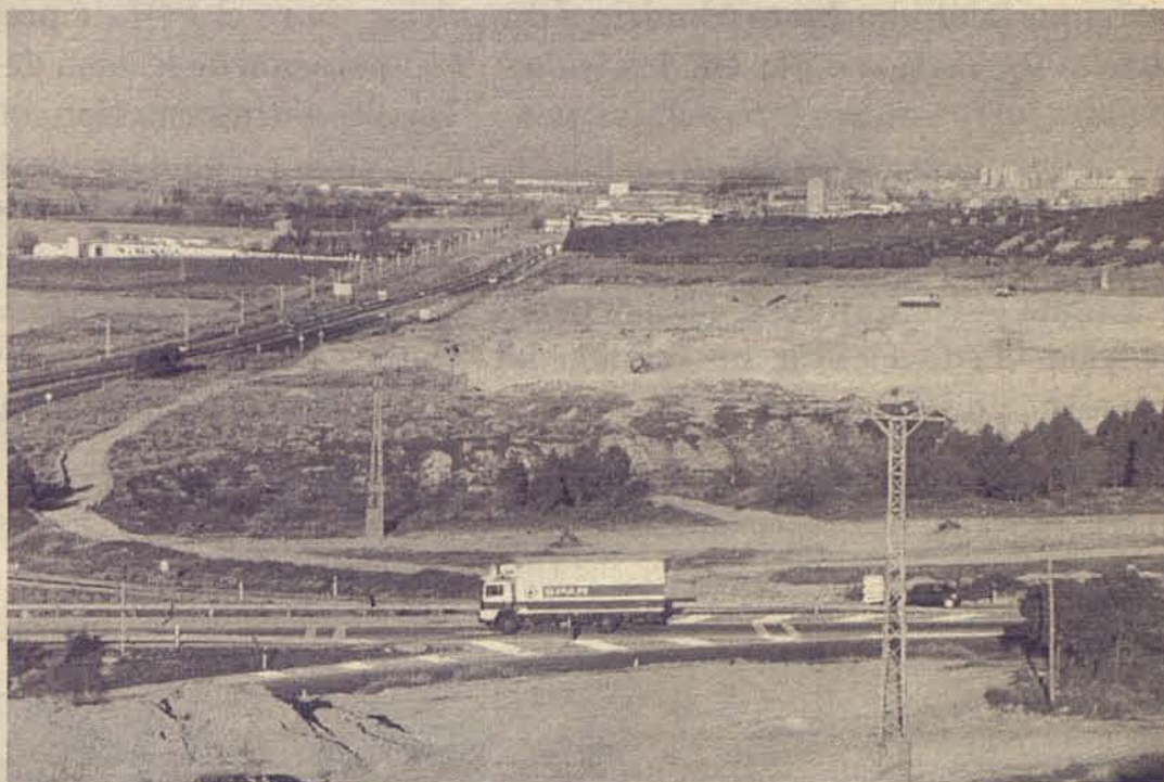
Foto archivo: Zona de contacto, durante las obras del nudo de la variante
