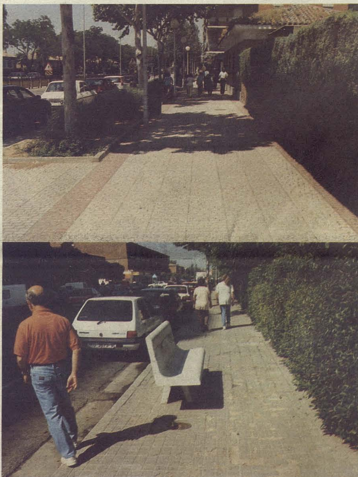
Arriba acerado de Avda. Barber, abajo acerado C/ Alberche
