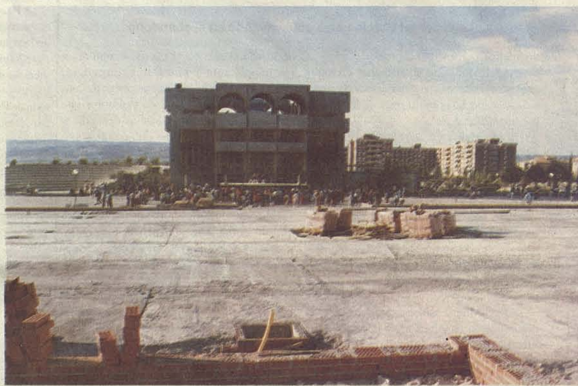
Obras: Plaza Federico García Lorca queda abrazada por los bloques de las viviendas sociales y el Centro Cívico
