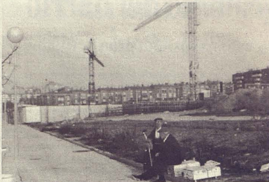
El Centro Social Polivalente, tiene que recoger las aspiraciones y necesidades del barrio. (Peatonal sin bancos, al fondo obras del centro).
