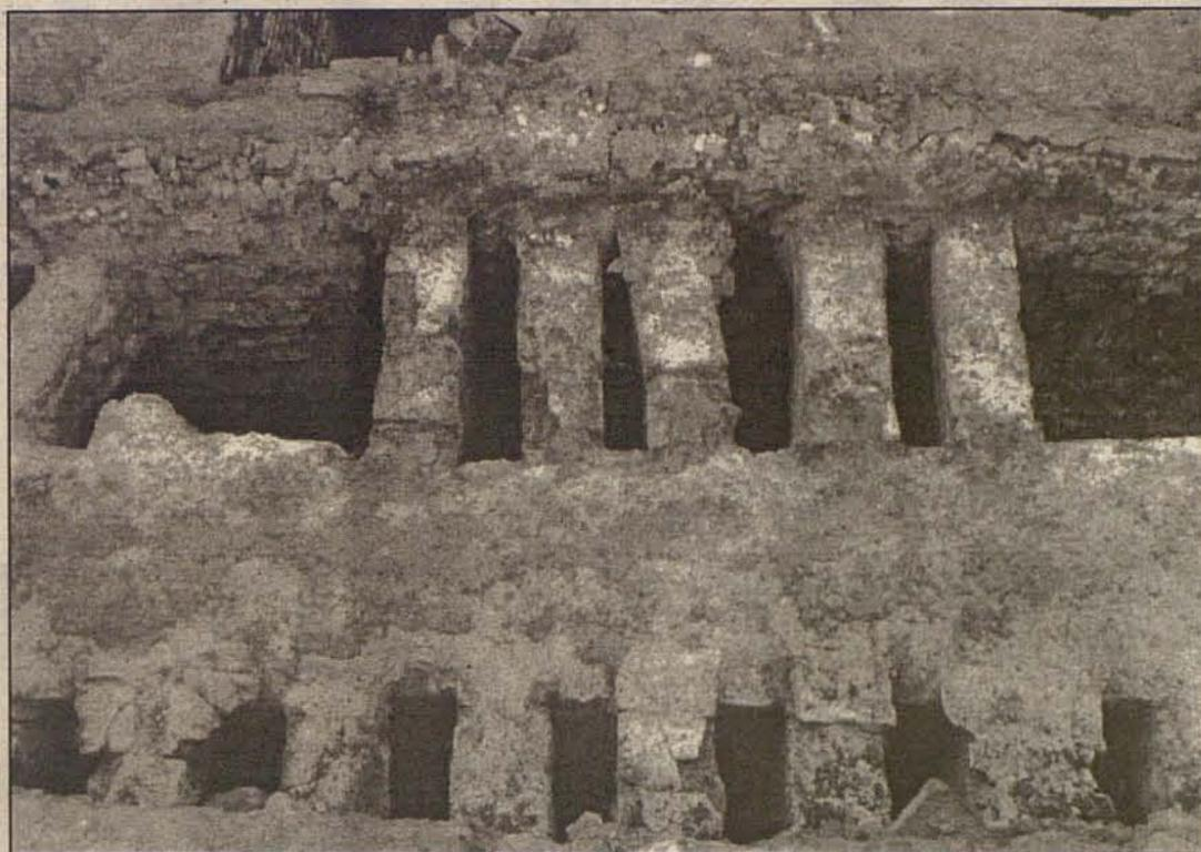
Fig. (2). Rejilla de separación entre la caldera y la cámara de cocción; toda ella está construida de ladrillos. Al fondo se aprecia parte de la pared de cierre de la cámara de cocción que se encuentra bastante deteriorada.
