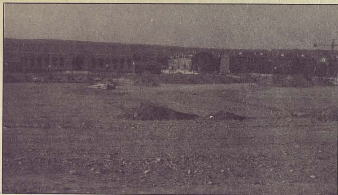
Obras del Parque Público de 1ª y 2ª fase, con una inversión de 54 millones.
