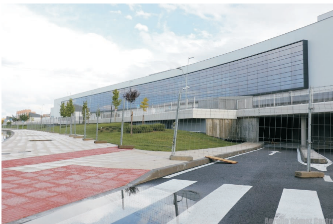
El hospital sigue en obras y sin fecha de apertura.
