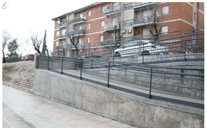
La nueva rampa peatonal.
