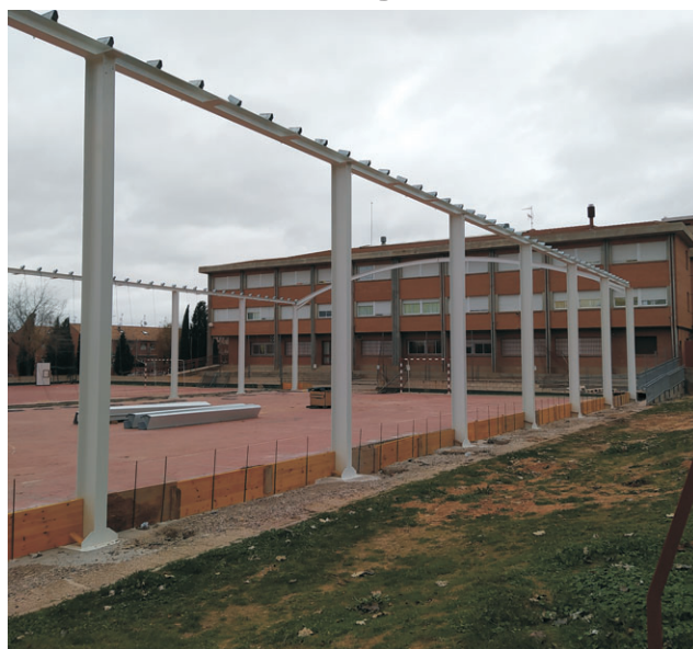
Obras del colegio Gómez Manrique.
