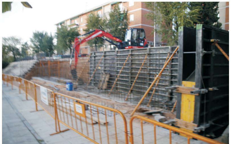
Obras para la rampa de Tiétar.
