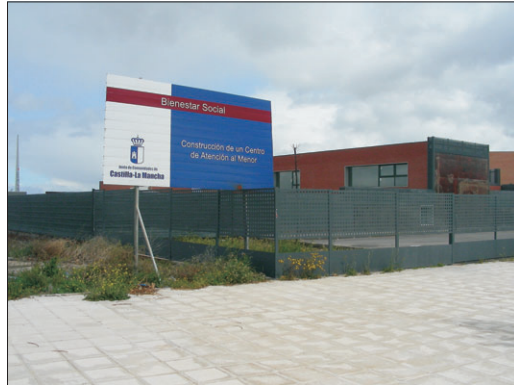
Este edificio de la Junta, aun sin uso, ha sufrido actos vandálicos.
