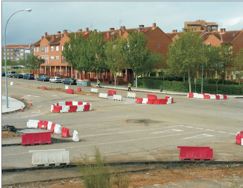
Obras del Fondo Estatal de Inversión Local, en la intersección de Boladiez con Ventalomar, ha comenzado la primera de ellas.
