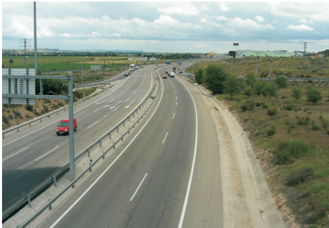
La Asociación de Vecinos considera que la nueva entrada que proyecta el concejal para los centros comerciales (a la derecha de la foto), no es incompatible con la urgencia del tercer carril de salida desde la C/ Jarama.
