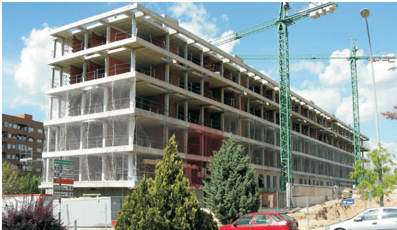
La Junta está construyendo 161 viviendas bioclimáticas -de VPO- en Boladiez con Guadarrama.
