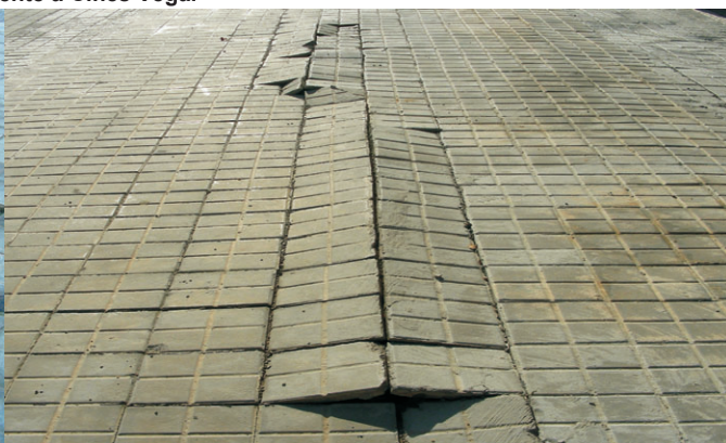
Aspecto de otras dos zonas de acerado. A la izquierda se produce por el hundimiento de alguna canalización, a la derecha levantamiento por una mala realización en las juntas de dilatación. Estos defectos están en una zona de 50 mts. junto a las dos fotos de arriba.
