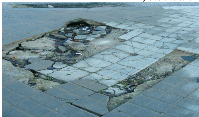
Aspecto de otras dos zonas de acerado. A la izquierda se produce por el hundimiento de alguna canalización, a la derecha levantamiento por una mala realización en las juntas de dilatación. Estos defectos están en una zona de 50 mts. junto a las dos fotos de arriba.
