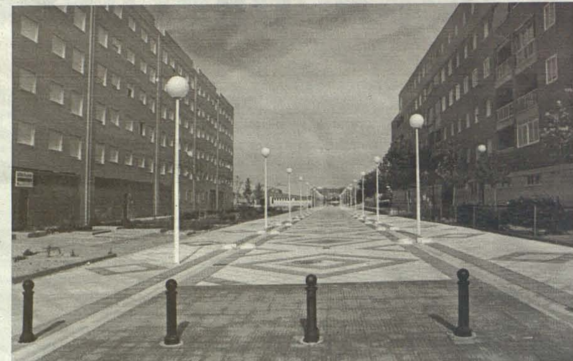
Peatonal Gregorio Marañón a falta de bancos y arbolado.
