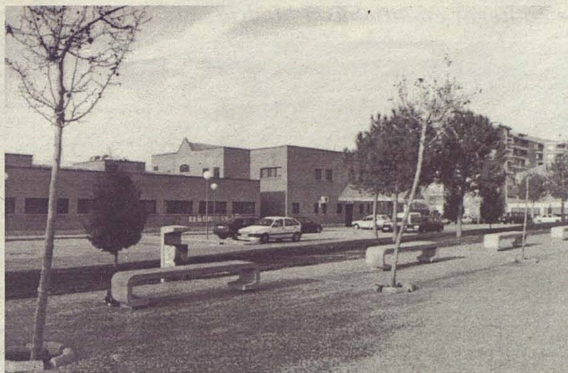
Vista Centro Salud del Barrio
