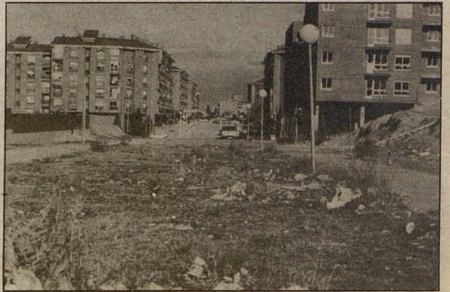
Peatonal Gómez Manrique, tramo desde las 825 viviendas sociales al colegio Juan de Padilla, unos 600 niños y sus familias transitan diariamente por él. ¿Presupuesto para su arreglo? o al menos limpieza.
