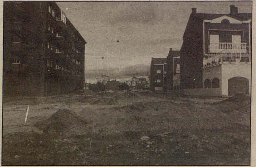
Obras de la Peatonal Río Guadalupe, que prolongará, la peatonal G a Lorca y Juan Pablo II. La obra comprende desde Río Bullaque a Valdeyernos
