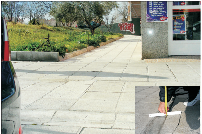
A esta altura de Guadarrama entre Alberche y Valdemarías se diseñó el paso de peatones, como muestra la zona sombreada en el centro de la foto, ahora que se ha decidido no realizarlo queda un escalón de dos cm. como muestra el detalle de la foto pequeña.
